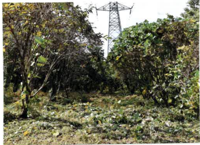
・作業後 Cエリア除草終了
